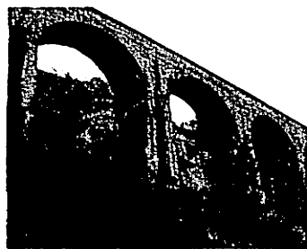
コンクリート・アーチの汐首陸橋
